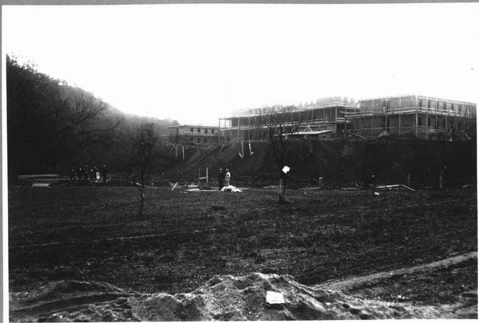
Výstavba „H“ a úprava zemní — 8. XI. 26.
