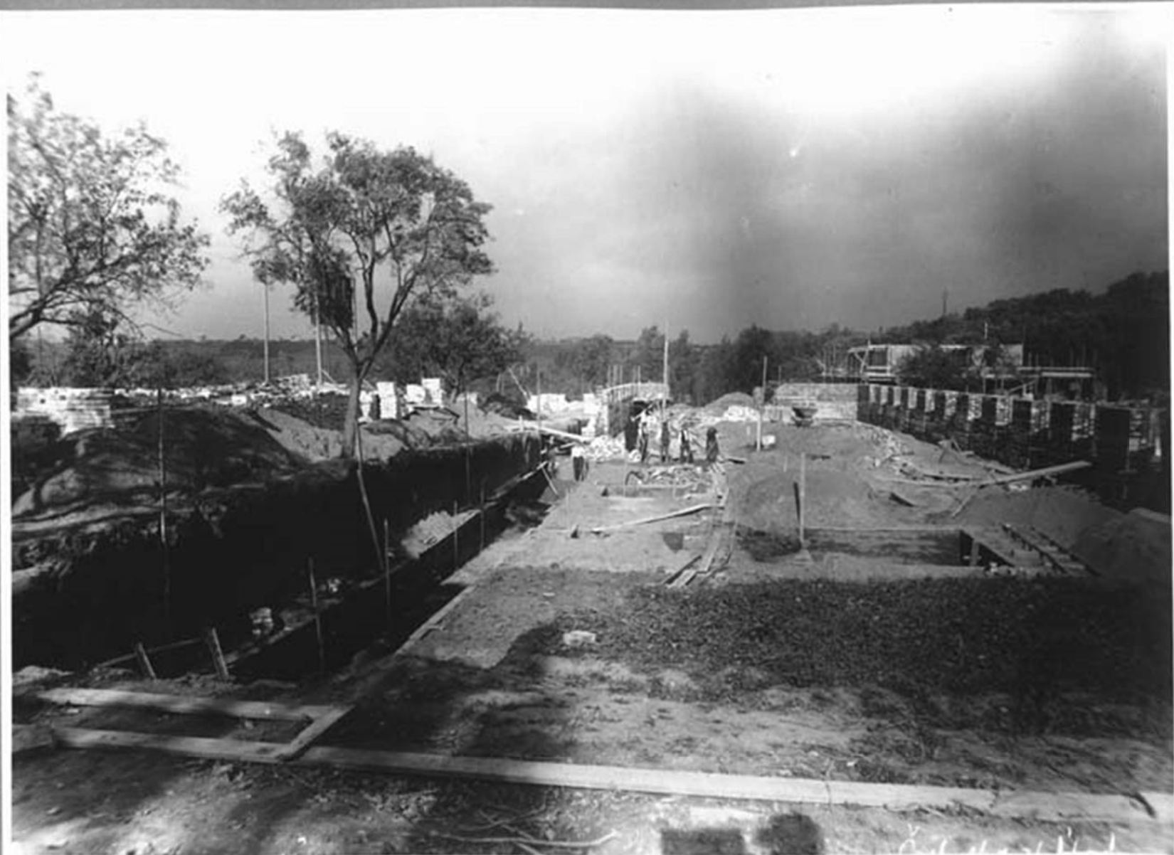
Výkop pro „A 4“ 16 10. 26.
