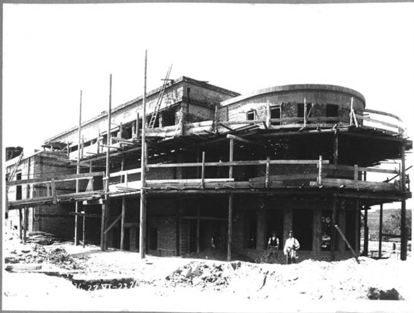
Výstavba „M“ 23. VII. 27.
